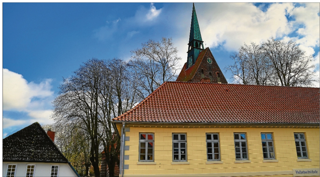
Gebäudeensemble mit Kirche und dem Bavendamschen Haus, in dem die Volkshochschule beheimatet ist.
